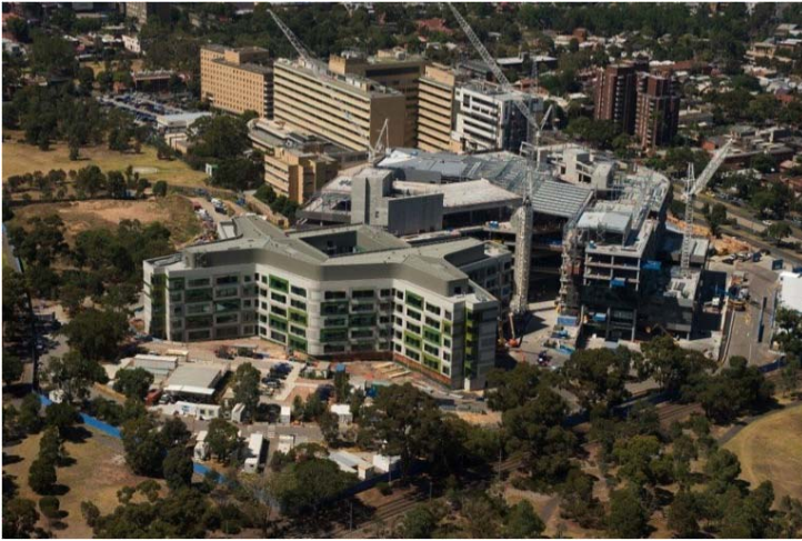
Actual construction status photo (March 2010)
